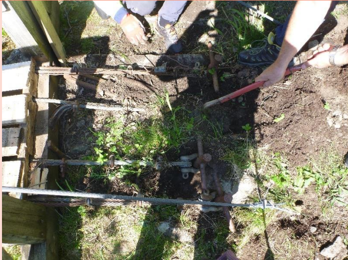
Figur 6: Forankring av bærekabler akse 1-3.
