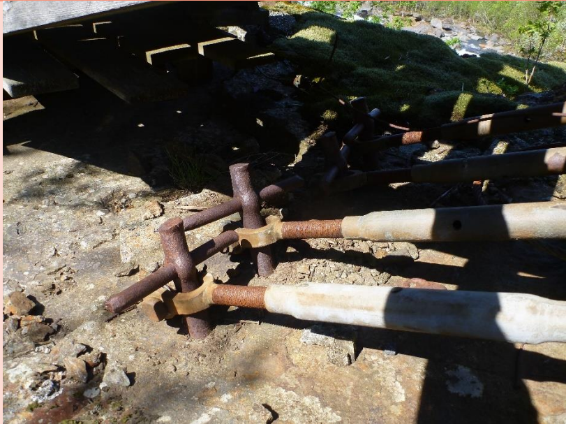
Figur 5: Forankring av bærekabler akse 1-2
