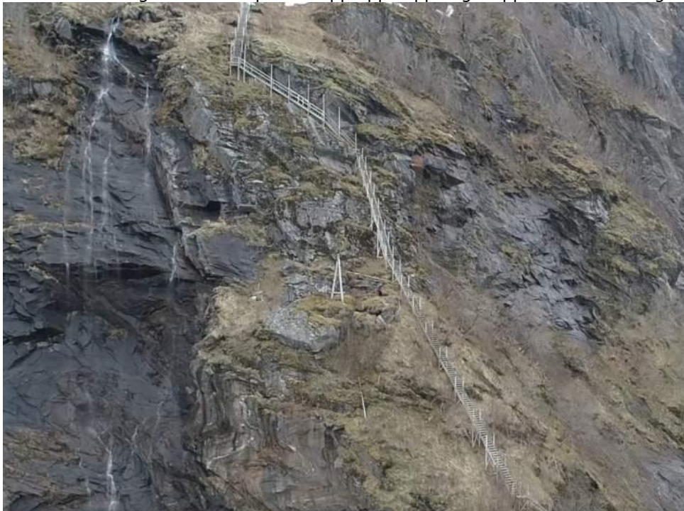
Seksjon 4 – Rettstrekk pluss overheng (Ca. 290 - 340 moh). Tretrapp forankret til berg. Rettstrekk pluss trapp opp klippe og trapp under overheng.
