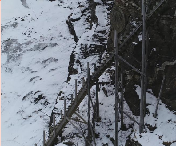
Figur 16: Tre akser med søyler av kreosotimpregnert rundtømmer vist. Foto tatt med drone 2020.
