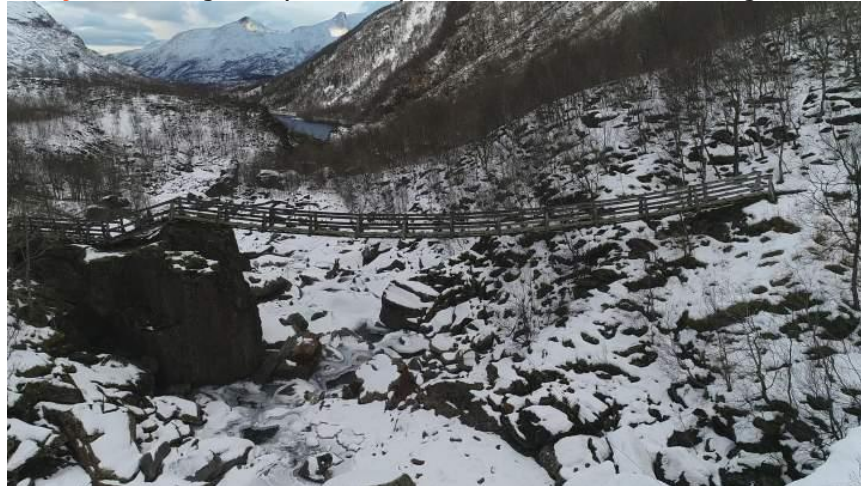
Seksjon 1 - Hengebru (160 moh). Bærekabler i stål, dekke og rekkverk i tre.
