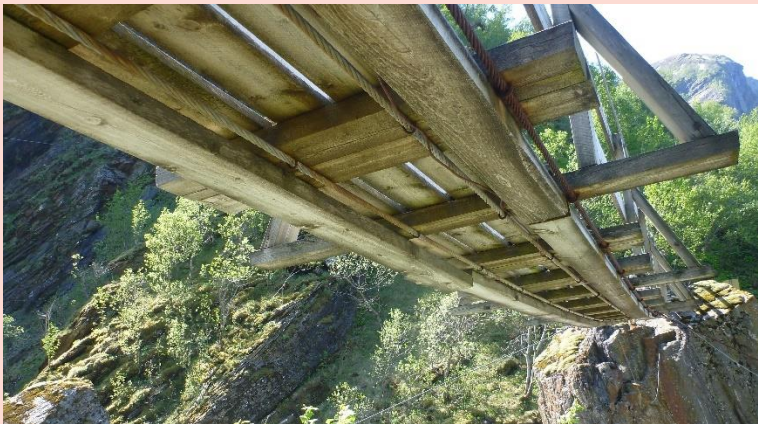
Figur 3: Fire stålvaiere bærer bruoverbygningen.
