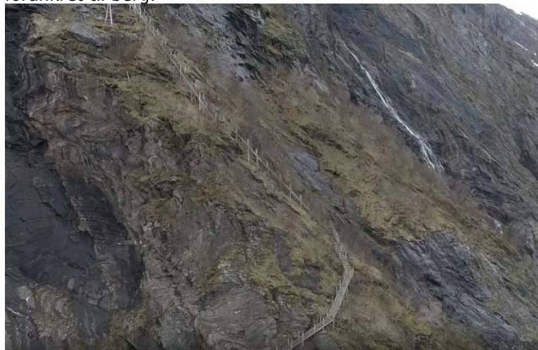
Seksjon 3 - Trapp med sving før rettsrekk (Ca. 270 - 290 moh). Tretrapp forankret til berg.
