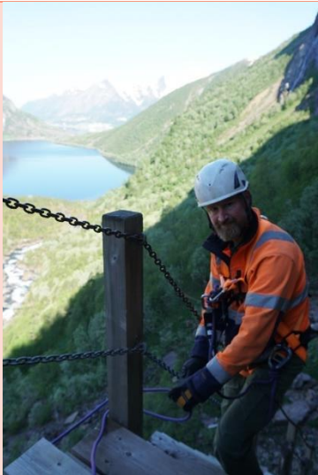
Figur 23: I eksponerte områder i seksjon to er rekkverket supplert med en ekstra kjetting.
