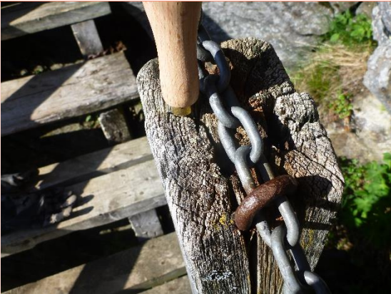
Figur 30: Søyle nær toppen av seksjon 4. Trolig fra da trappa var ny.
