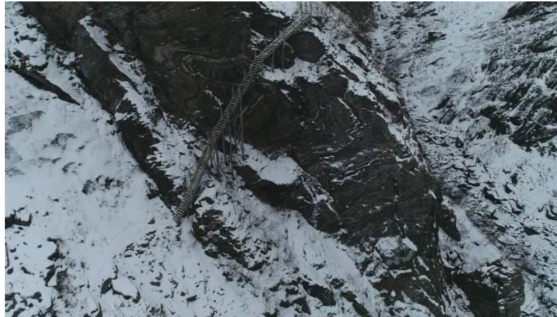
Seksjon 2 - Trapp opp bratt klippe (Ca. 240 - 270 moh). Trapp restaurert etter å ha blitt tatt av ras.
