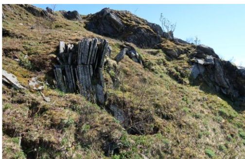
Bilde 22: Forvitring av berggrunnen skaper avskallinger av fjell
