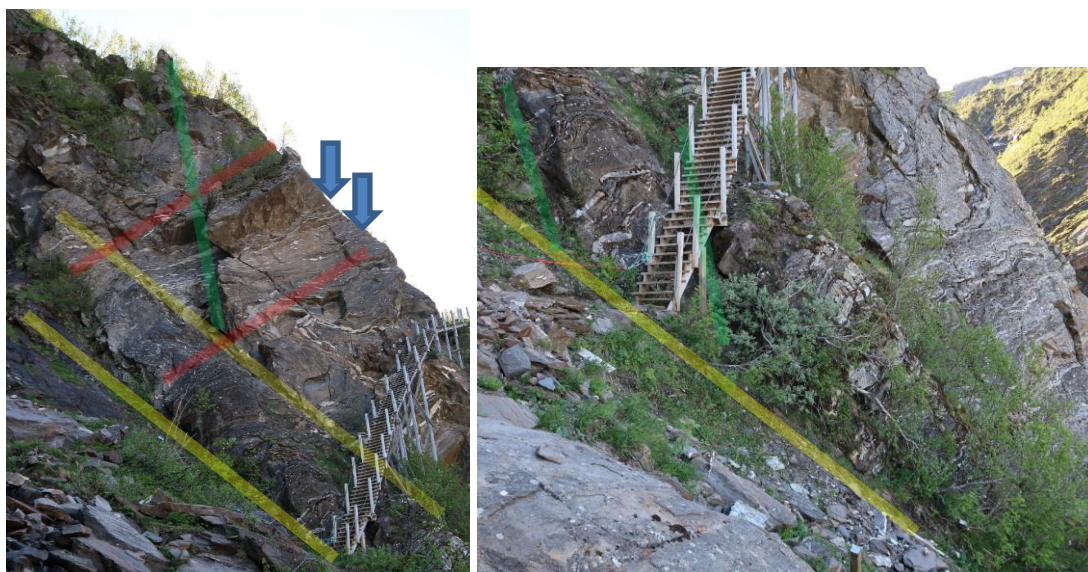
Bilde 3 og 4: Avløste fjellblokker (gul strek nær overflateparallele sprekker, rød sprekker nær parallelt foliasjonen, grønn strek steile tverrsprekker og åpning i berggrunnen pga tidligere bevegelse av bergmassivet og pilene viser ca plassering av de avløsende baksprekkene som vises i bildene 5-7
