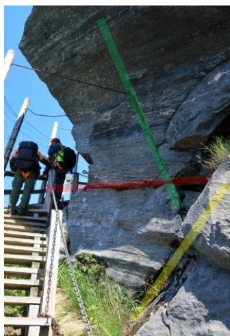
Bilde 12 Avspent fjellområde, bør overvåkes (gul strek nær overflateparallele sprekker, rød sprekker nær parallelt foliasjonen, grønn strek steile tverrsprekker)
