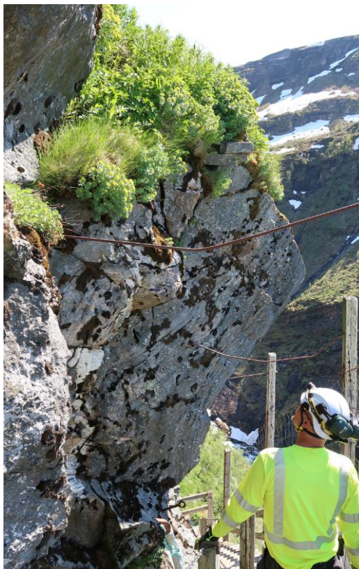
Bilde 16 og 17: Stedvis ny risstdannelse og løse blokker ovenfor trappa. Området foreslås sikret med nett og overvåket.
