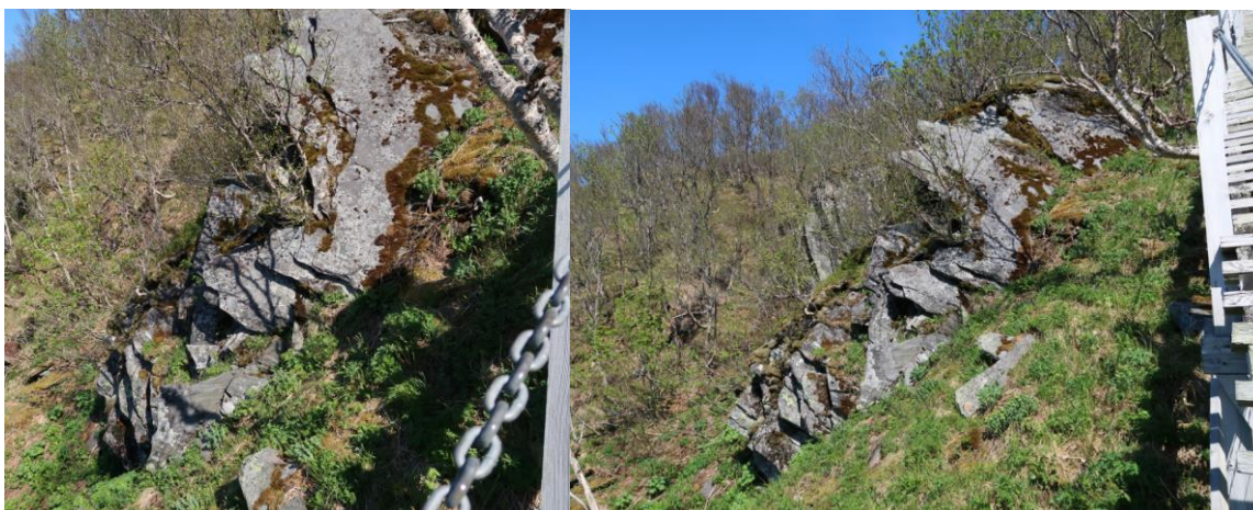
Bilde 18 og 19: Området sikres med lett spettrensk der stein kan løsne og nå trappa
