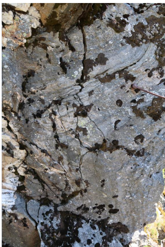
Bilde 16 og 17: Stedvis ny risstdannelse og løse blokker ovenfor trappa. Området foreslås sikret med nett og overvåket.
