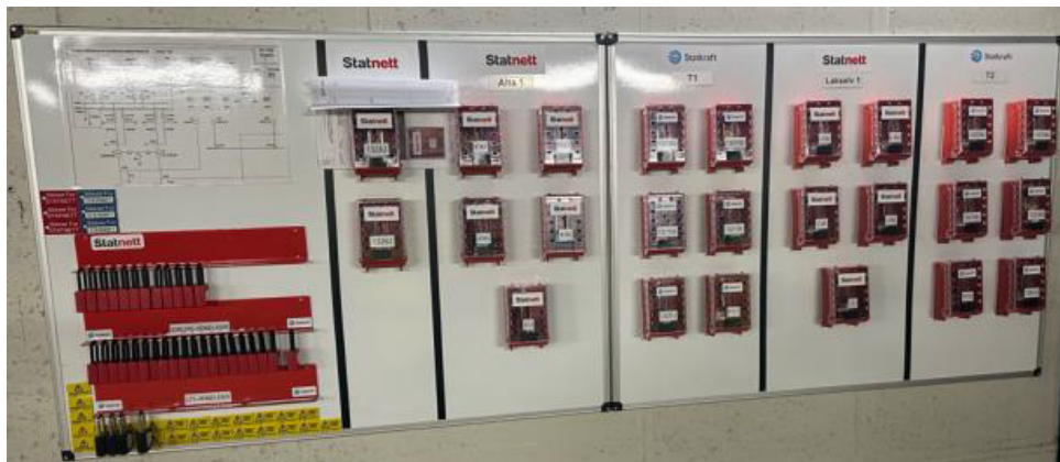
Eksempel: LOTO bokser med Key Alike pr. bryter plassert feltvis
