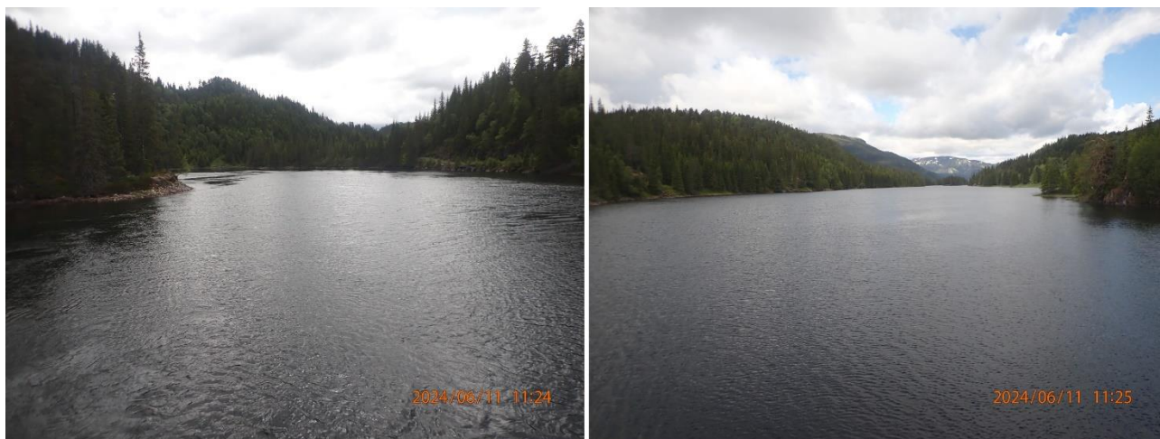
Figur 0-5. Foto tatt ved hengebru om lag 2 km oppstrøms dammen. Det er nevnt at bunnkoten i dette området ligger over kote for planlagt senkning, slik at dette vil medføre oppstuvning og derav redusert senkning i innsjøen oppstrøms. Foto t.v.: nedstrøms bru. Foto t.h.: oppstrøms bru. Foto tatt på vannstand +464,7 (HRV – 0,8 m).
