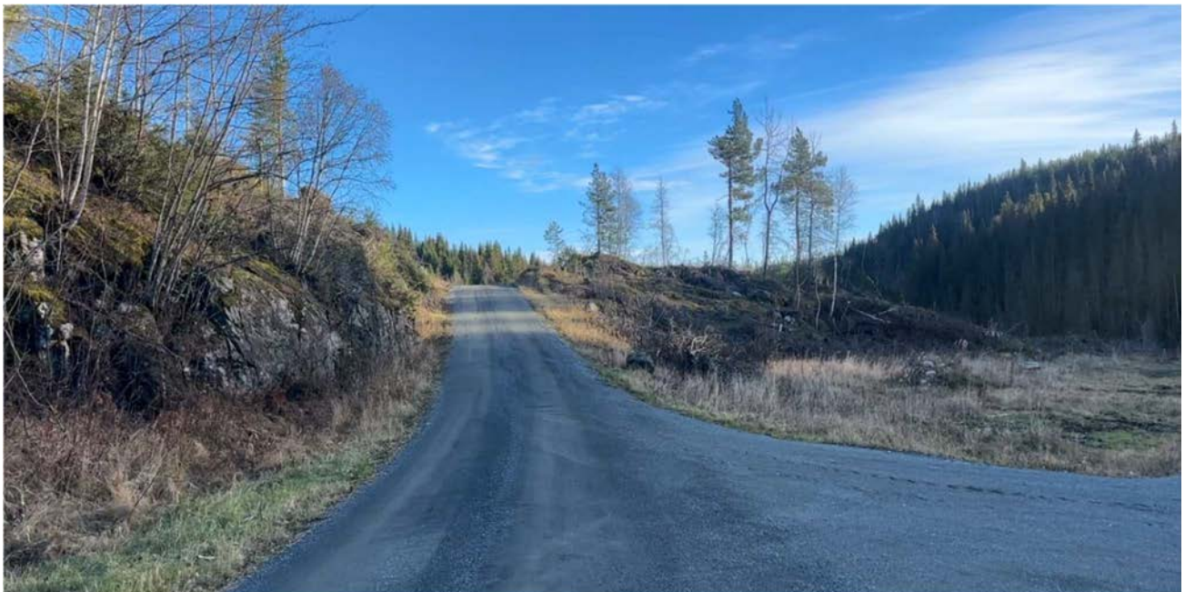
Figur 8 Bilde mot øst ved parkeringen viser avkjøring mellom øvre og nedre utfyllingsområde på hhv. venstre og høyre side. Øvre bergkulle til venstre og nedre bergkulle til høyre i bakgrunn ved toppen av veg.
