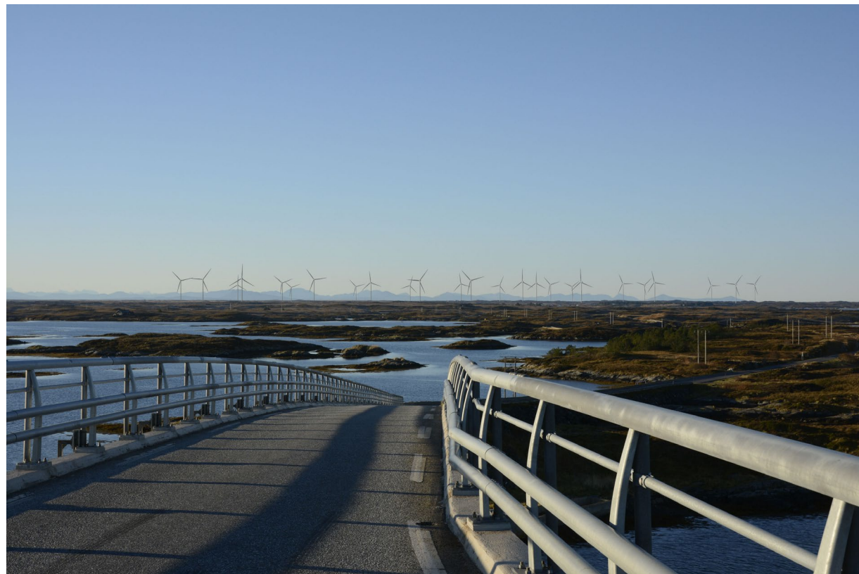
Nye Smøla vindkraftverk total høyde 220 m
