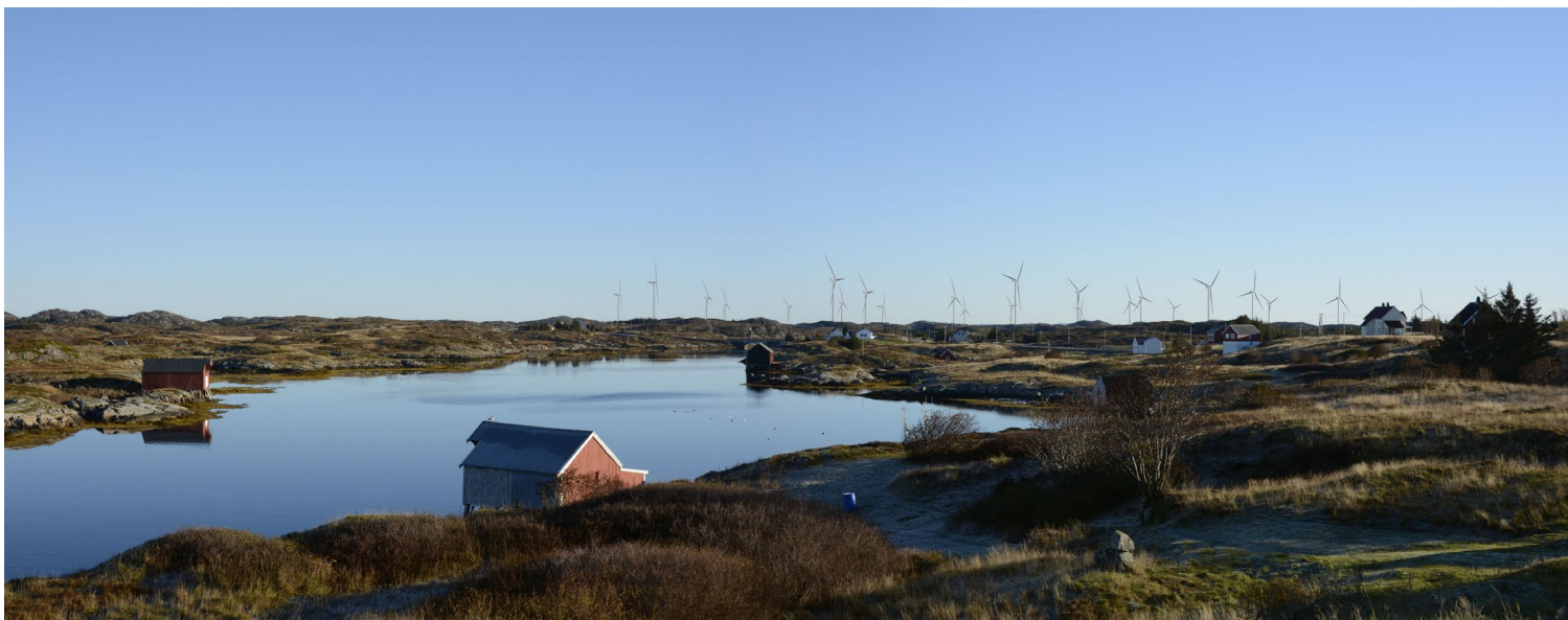
Nye Smøla vindkraftverk total høyde 220 m
