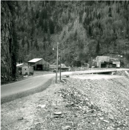
Anleggsområde Lio A-tunell
