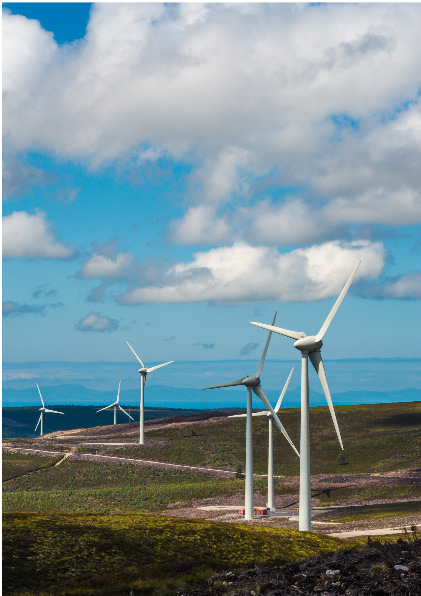
BERRY BURN VINDPARK , i Highlands-området i Skottland
