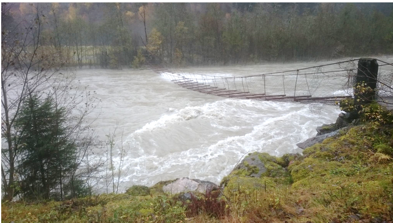
Under et ekstremt regnvær i oktober 2018 klarte Statkraft å vesentlig redusere omfanget av en større flomsituasjon, fra en 50-årsflom til en 20-årsflom.
