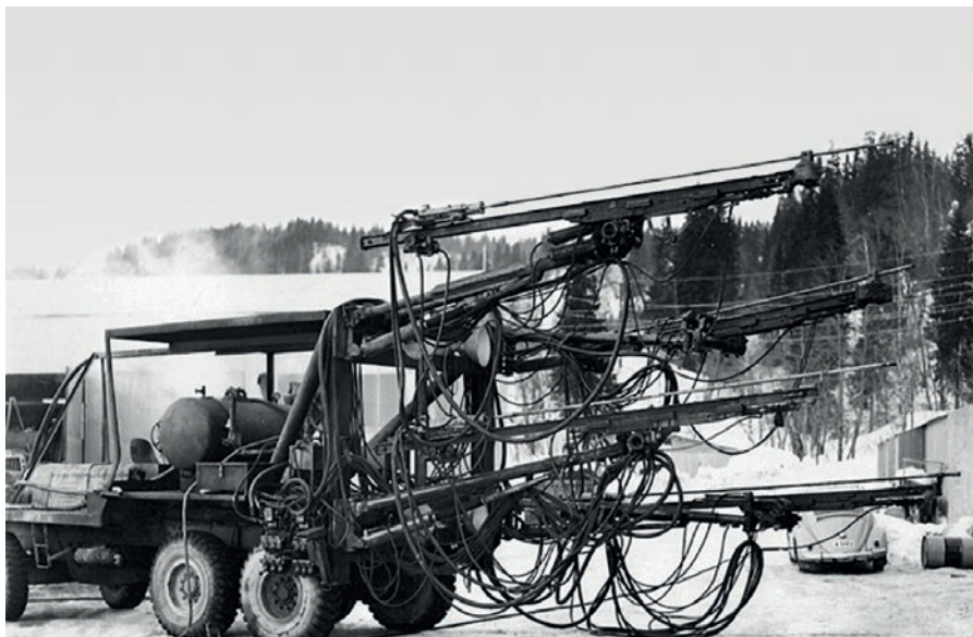
Borerigg ble for første gang tatt i bruk under byggingen av Langvatn kraftverk. Foto: Lind
