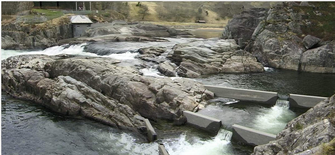
Figur 2. Søndre fisketrapp i Sandsfossen ved lav vannføring.
