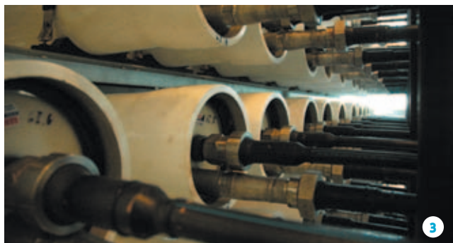
1: Saltkraftanlegget på Tofte i Hurum. 2: Vannet renses for humus og andre partikler før det ledes inn i membranene. 3: Membranene er rullet opp inne i trykkrør. 4: Trykket ledes inn i en turbin som driver en strømgenerator.
