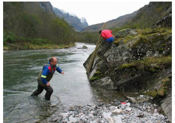
Nytt vannmerke i Litledalselva under montering
