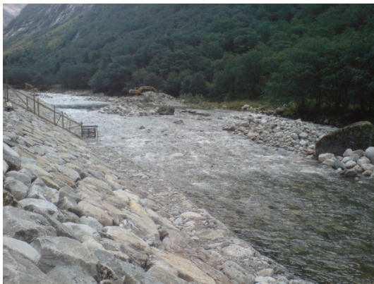
Terskler og forbygningar
