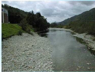
Bævra ved utløp Svorka kraftverk
