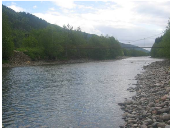
Bru oppstrøms Svorka kraftverk
