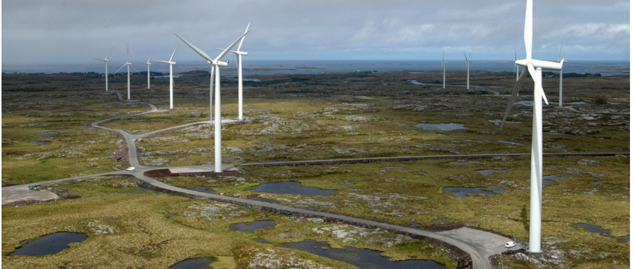
Smøla vindpark i Møre og Romsdal er Norges største vindkraftverk
