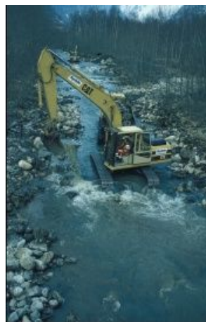
Bygging av tersklar
